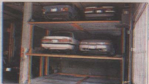
Un système de passerelles électriques permettra d'empiler trois véhicules sur l'équivalent d'une place de stationnement.
