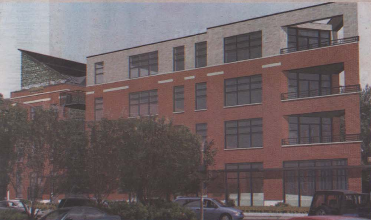
Un triplex qui n'aura pas besoin d'être alimenté en énergie par Hydro-Québec sera construit à Verdun d'ici l'automne prochain. Le bâtiment produira autant d'énergie qu'il en consomme, notamment grâce à des panneaux solaires sur le toit (à gauche sur la photo).
